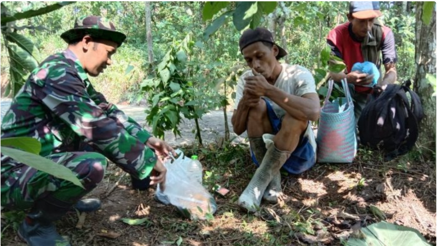
Di Sela Istirahat Pengecoran Jalan Serda Nurkolis Jalinan Silaturahmi Dengan Warga
