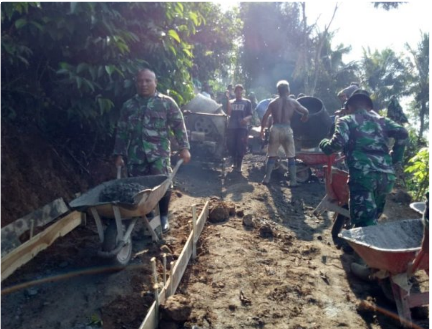
Satgas TMMD Kebut Pengecoran Jalan
