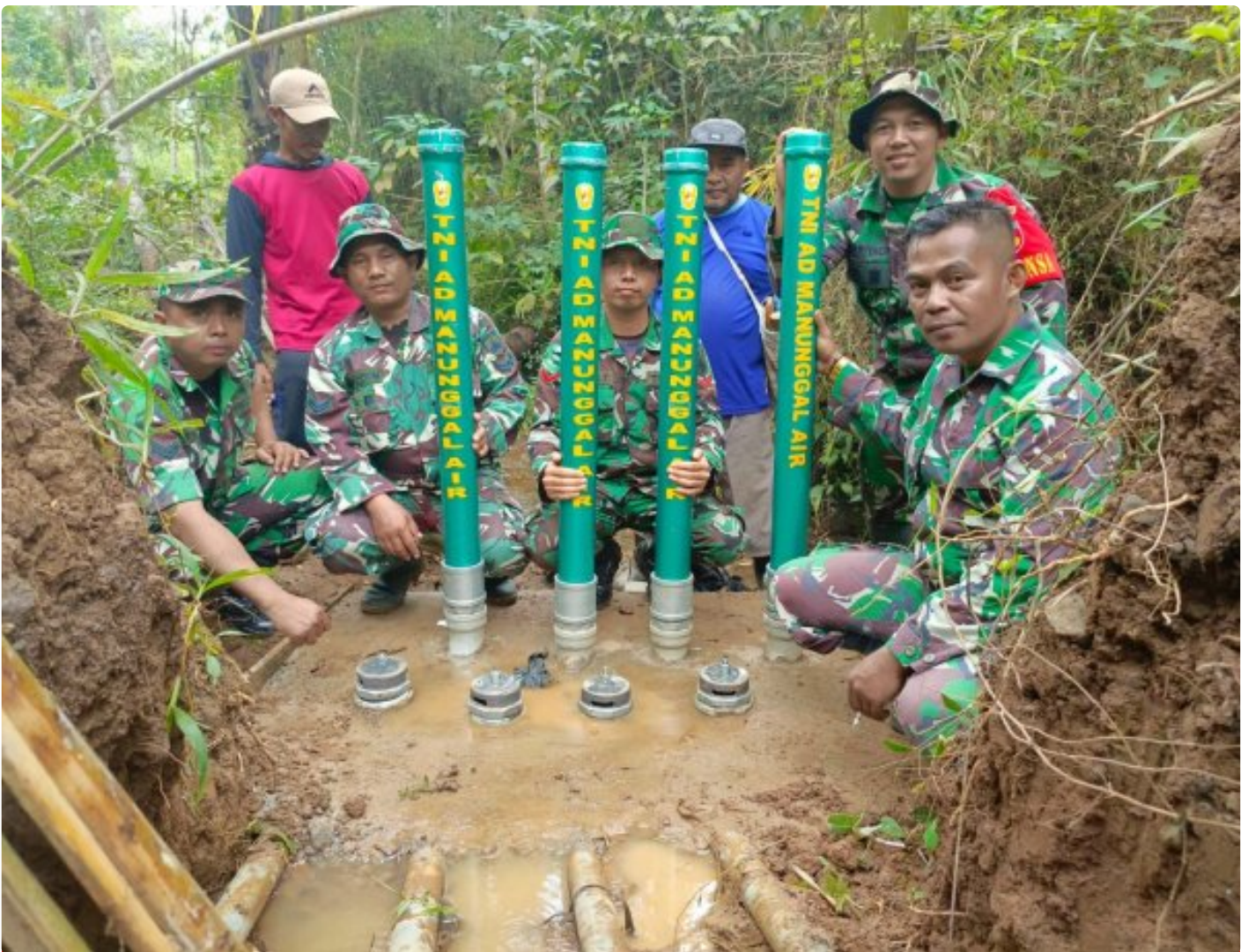
Footo; Pembuatan Pompa Air Hidran di Dusun Kalisalam Sukses Dilaksanakan
